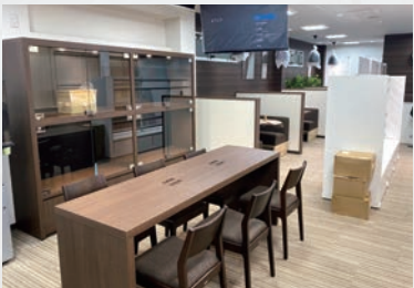
店舗の改修例。パーティションやペンダント照明などに特徴があります。
